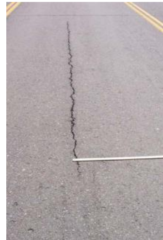
Longitudinal Crack
